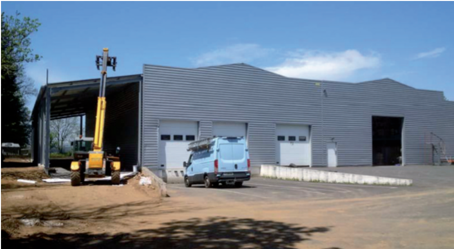
Extension en cours de la zone de stockage
