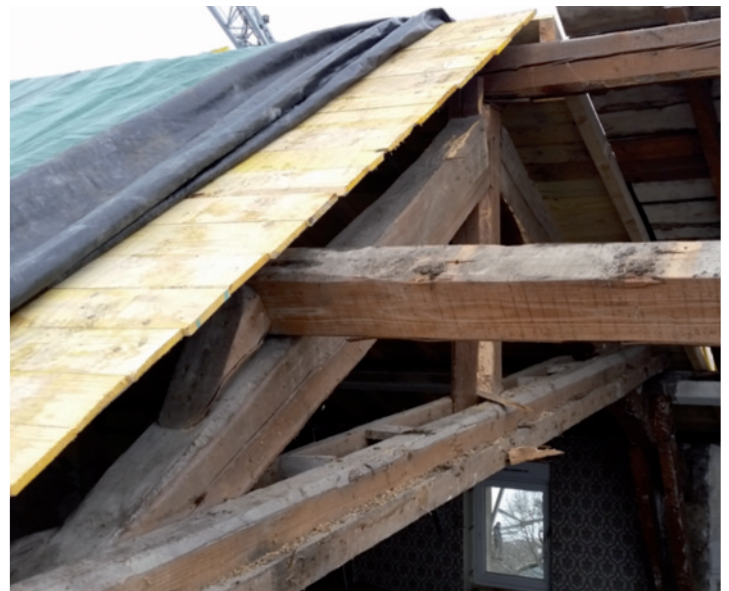
Réfection complète de la toiture du centre socioculturel
