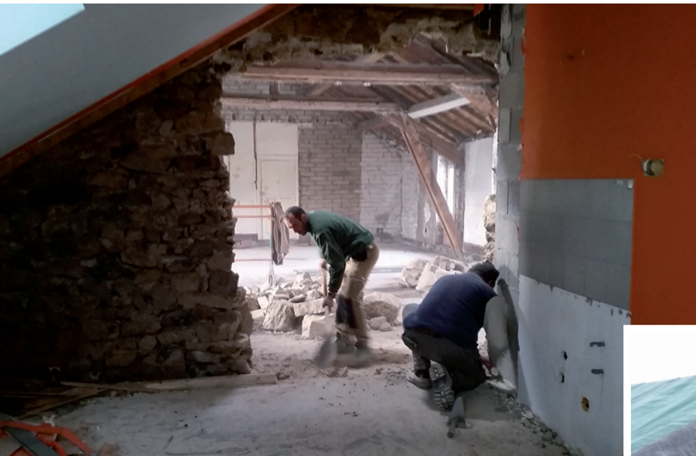
Ouverture d'un passage au 3 ème étage du centre socioculturel
