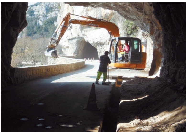
Travaux d'alimentation en eau potable dans les Gorges de l'Ardèche – Vallon Pont D'Arc (ci-dessus et à droite)
