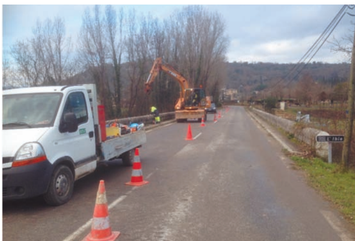
Travaux d'encorbellement dans les Gorges de l'Ardèche – Vallon Pont D'Arc
