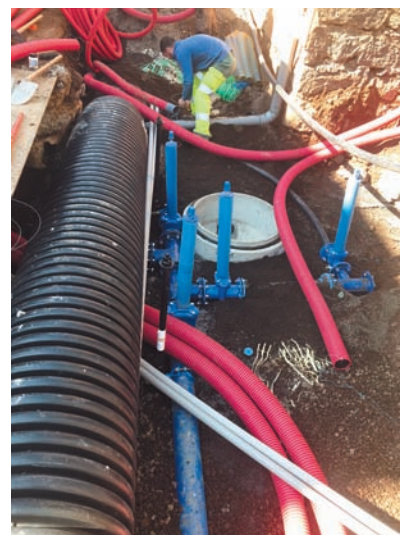
Pose de réseaux à Costaros (43)
