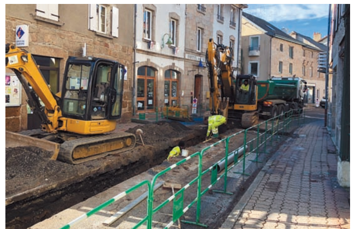
Travaux du centre bourg de Saint-Agrève
