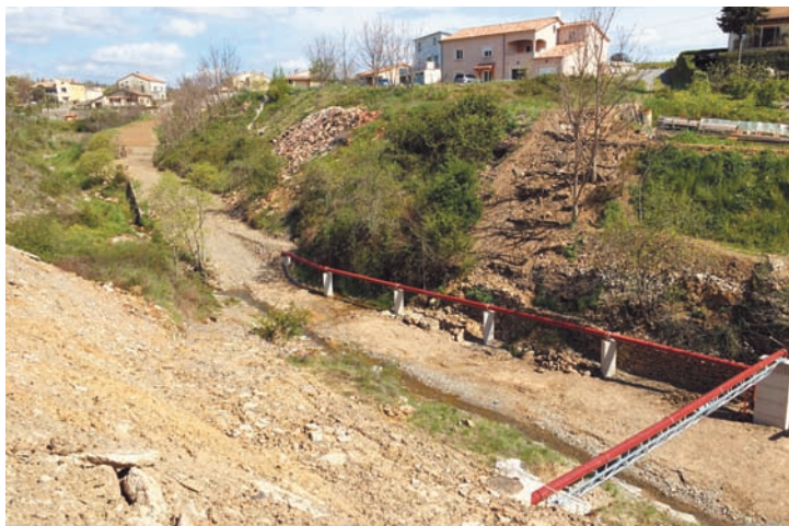
Réseau d'assainissement en encorbellement
