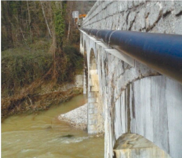
Travaux d'encorbellement dans les Gorges de l'Ardèche – Vallon Pont D'Arc
