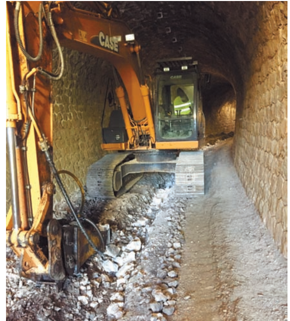
Travaux d'AEP au tunnel de Gastefer entre Saint-Agrève et Saint-Julien d'Intres
