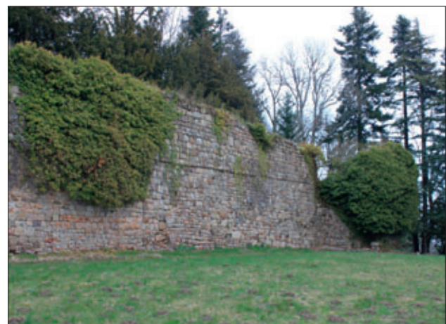
Mur du château
